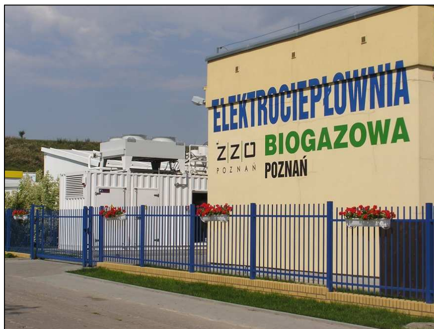
Rysunek 6. Biogazownia w Suchym Lesie
