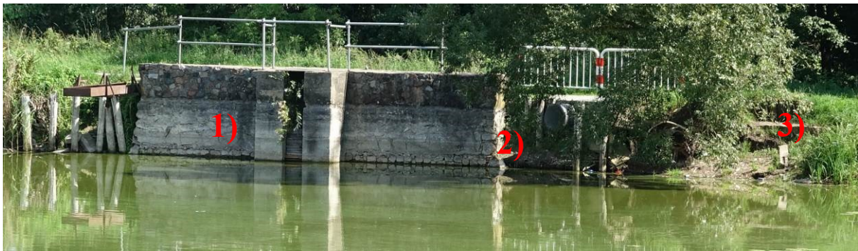
Ryc. 60. Budowla piętrząca Staw Błękitny elementy; wskazane elementy 1), 2) i 3)
