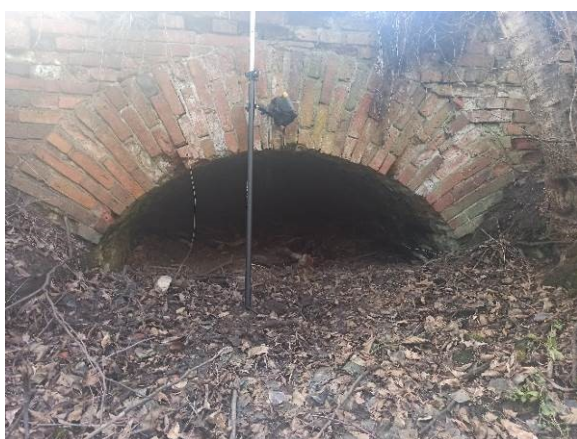
Ryc. 41. Widok na wylot przepustu od strony DW
