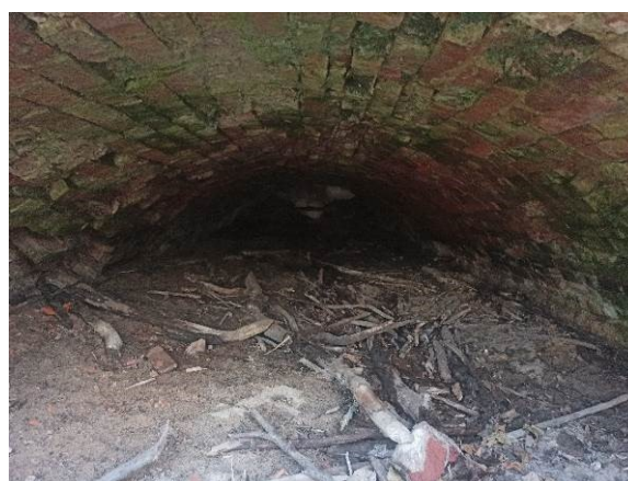
Ryc. 42. Widok wnętrza przepustu pod drogą od strony DW
