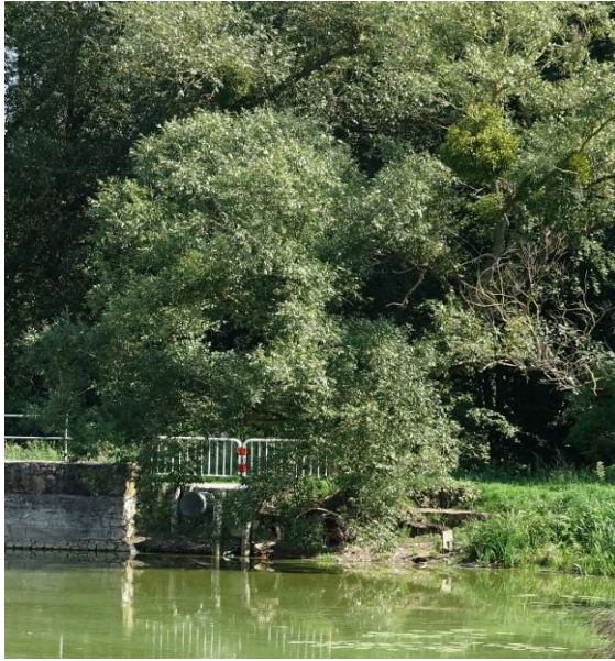
Ryc. 65. Drzewo w sąsiedztwie budowli upustowo-przelewowej – zagrożenie rozmyciem zapory ziemnej po upadku drzewa lub podmyciu korzeni.
