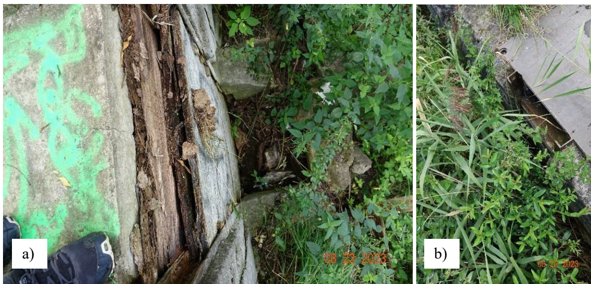
Ryc. 56. Zamknięcia przepustów a) całkowicie b) prawie całkowicie zasłaniające otwór przelewowy
