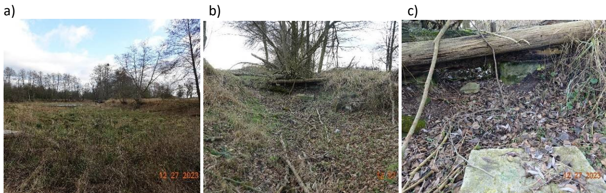
Ryc. 49. Widok na dopływ (a) i odpływ (b) – rów suchy. Pozostałości elementów przepustu na wypływie ze stawu przy punkcie czerpania wody (c).
