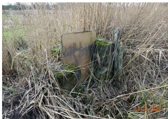
Ryc. 44. Widok na zastawkę na grobli
