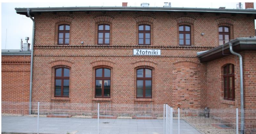
Zrewitalizowana stacja kolejowa w Żłotnikach
