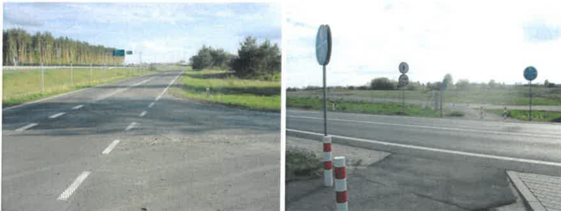
Drogi serwisowe przy węźle S-11
