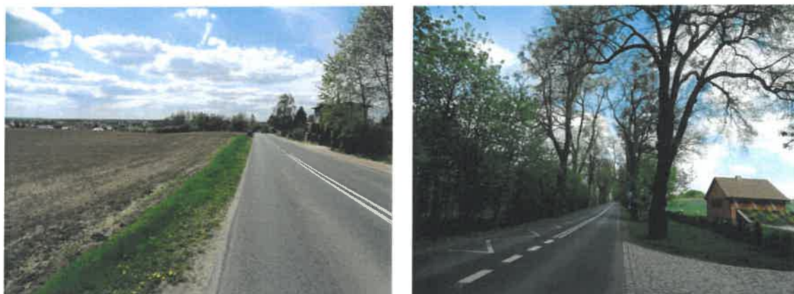
Ulica Południowa i Ulica Meteorytowa w kierunku Moraska
