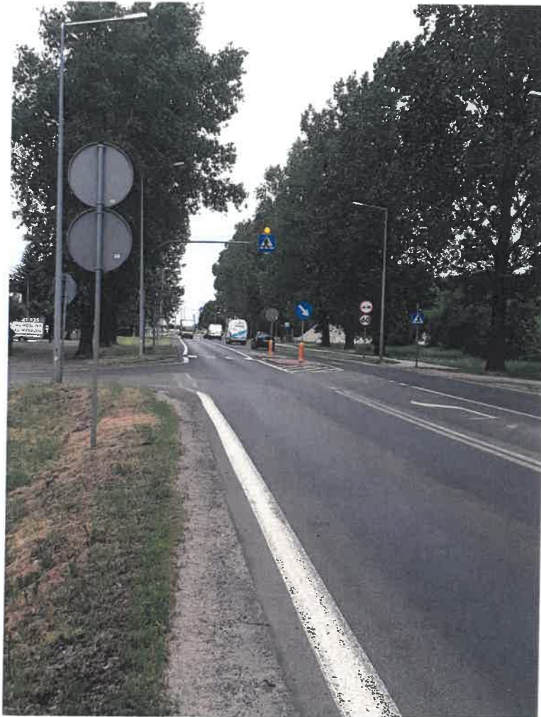
Fotografia 5 Posesja przy ul. Radosnej1B w Złotnikach, zabudowa mieszkaniowa jednorodzinna
