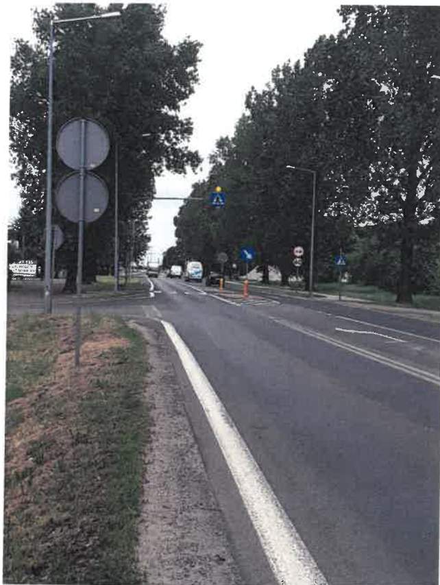
Fotografia 1 Skrzyżowanie dróg ul. Obornicka/ ul. Radosna w Złotnikach, widok w kierunku m. Złotkowo
