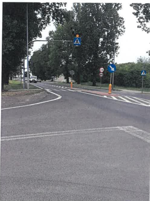
Fotografia 2 Fotografia 1 Skrzyżowanie dróg ul. Obornicka/ ul. Radosna w Złotnikach, widok od strony ul. Radosnej
