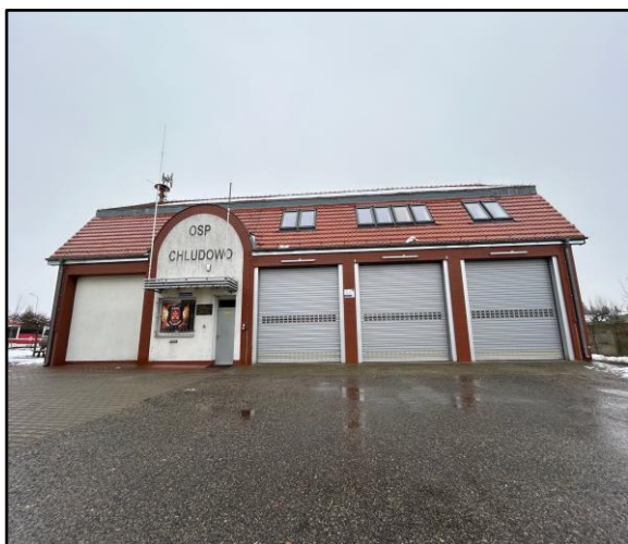
Remiza OSP i świetlica wiejska
