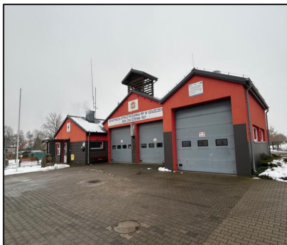
Remiza OSP i świetlica wiejska
