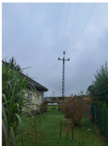
14. Linia energetyczna przecinająca ulicę Polną – widok w kierunku wschodnim
