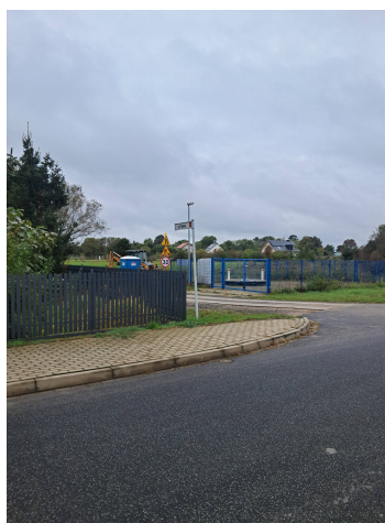
16. Widok z ulicy Polnej na przepompownię ścieków
