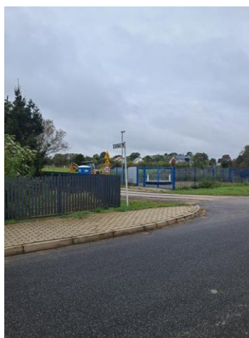
16. Widok z ulicy Polnej na przepompownię ścieków
