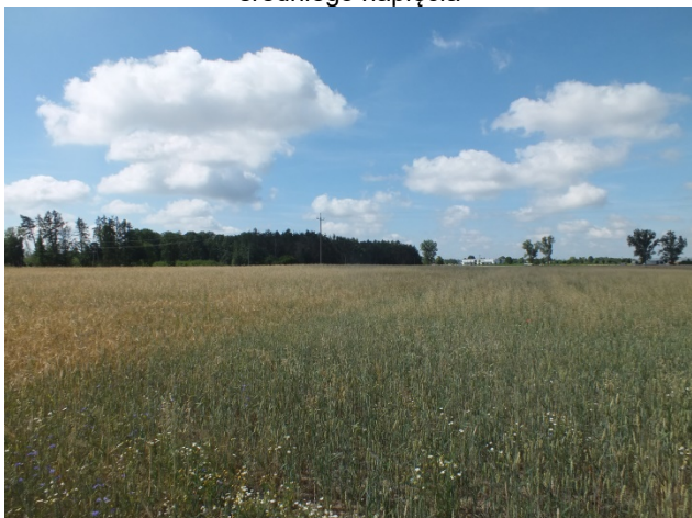
3. Widok na tereny upraw rolnych oraz linię napowietrzną średniego napięcia
