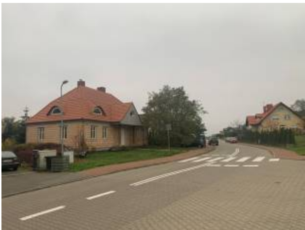
15. Ulica Dębowa przy skrzyżowaniu z ulicą Grabową
