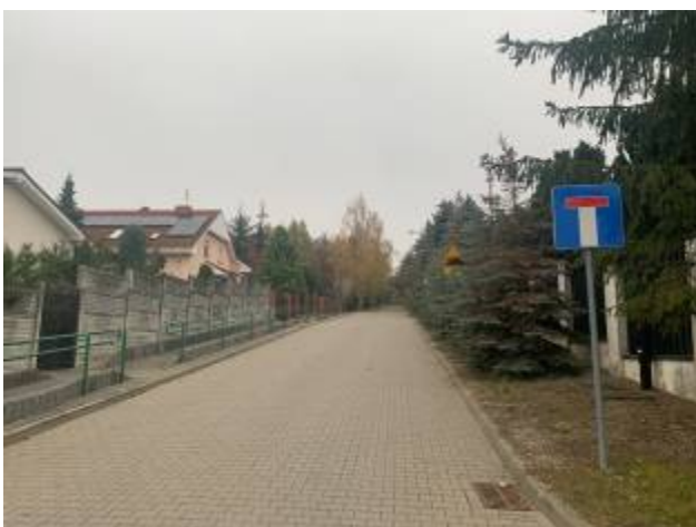
11. Ulica Podjazdowa przy skrzyżowaniu z ulicą Dębową – widok w kierunku północnym
